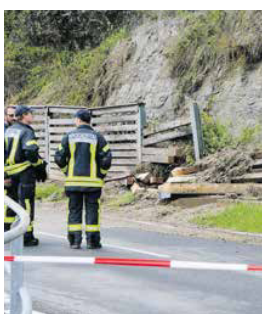
> 12: Erdrutsch verschüttete die Strasse zwischen Langnau und Richenthal. Foto-kl
